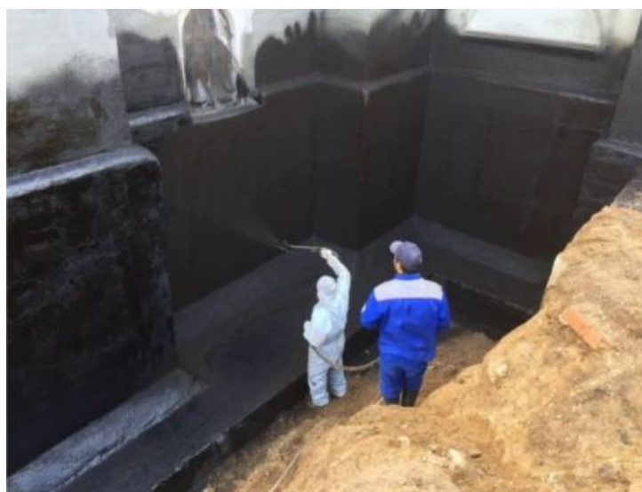
Рис. 6 – Восстановление гидроизоляции жидкой резиной
