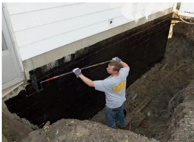
Рис. 4 – Восстановление гидроизоляции обмазочными составами
