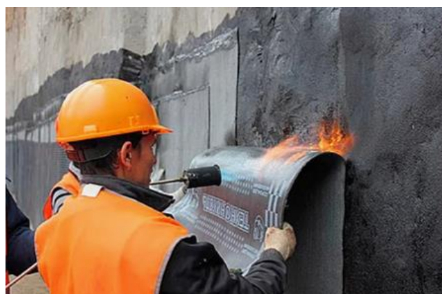
Рис 5 – Восстановление оклеечной гидроизоляции
