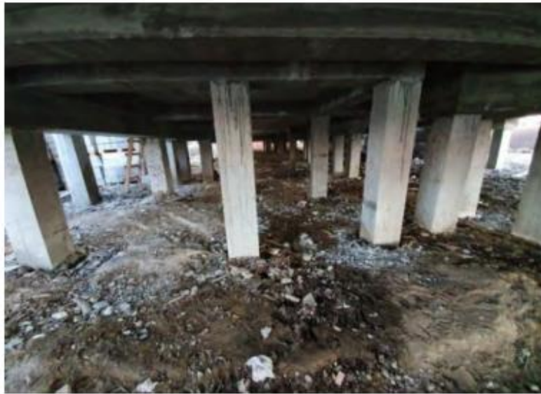
Рис. 1 – Естественная вентиляция мерзлой поверхности
