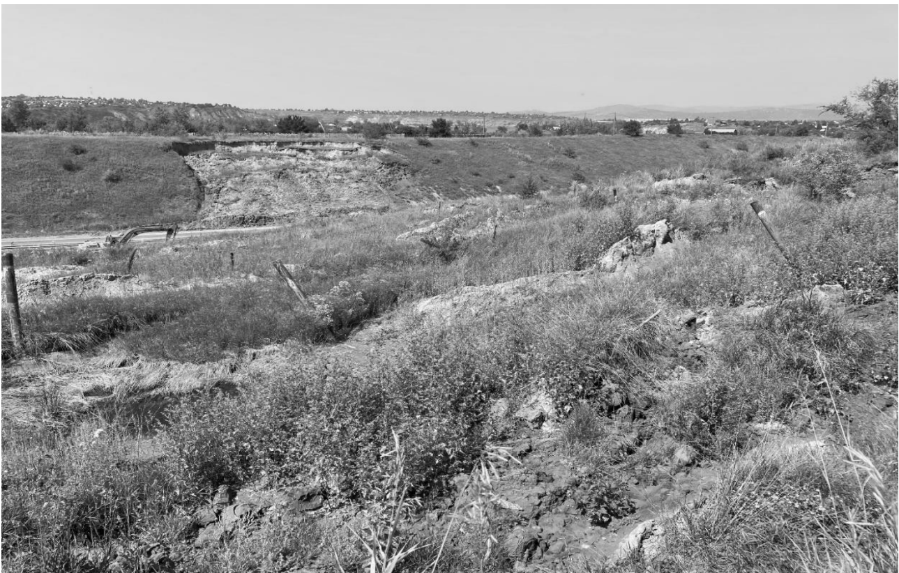
Рисунок 4 – Обнаженные поглощающие скважины в результате выборки грунтов оползневого массива
