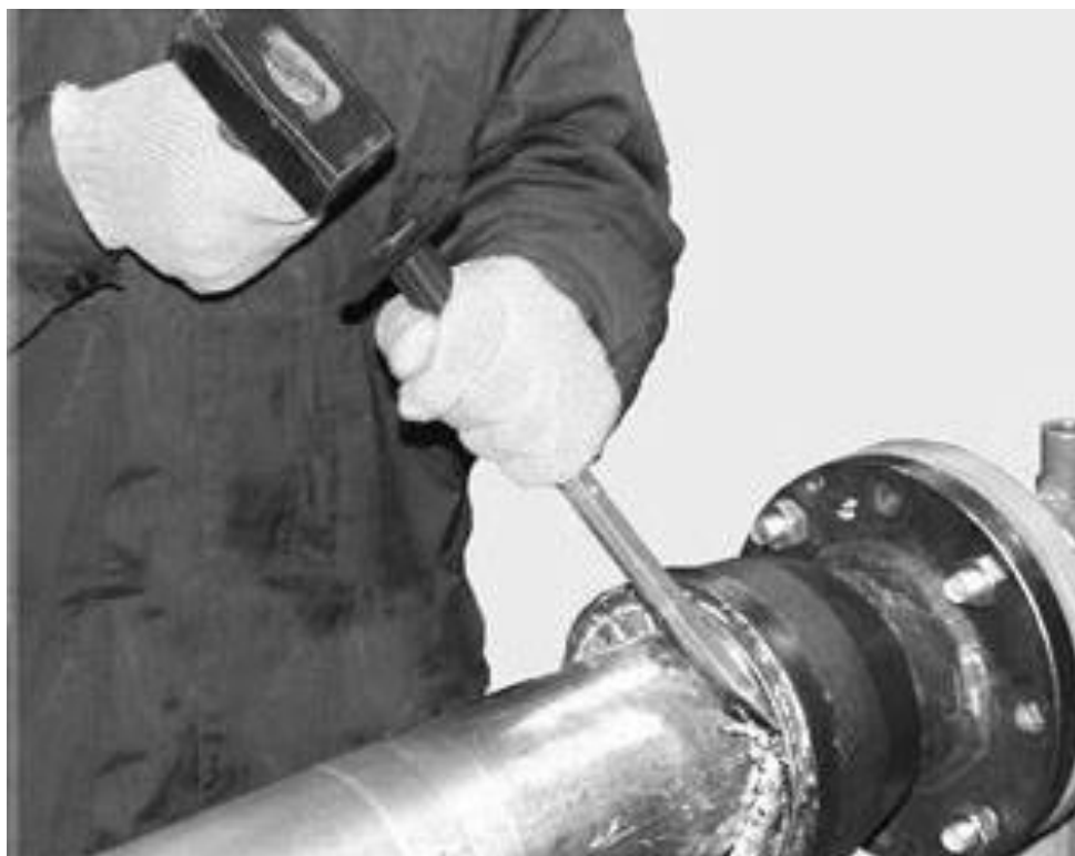
Рисунок 4 – Очистка торца раструба от выступающего свинца
