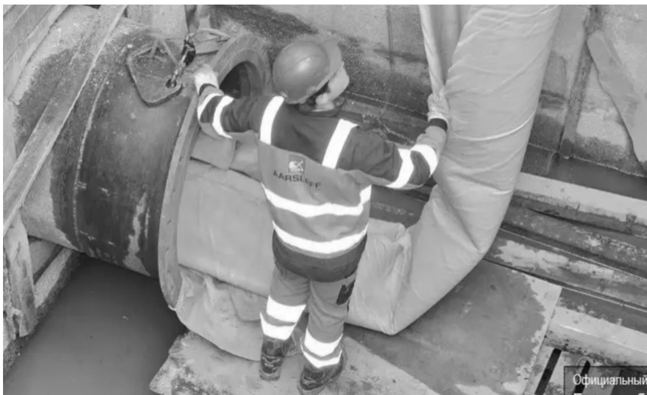
Рисунок 2 – Восстановление трубопровода комплексным рукавом «Бертос»
