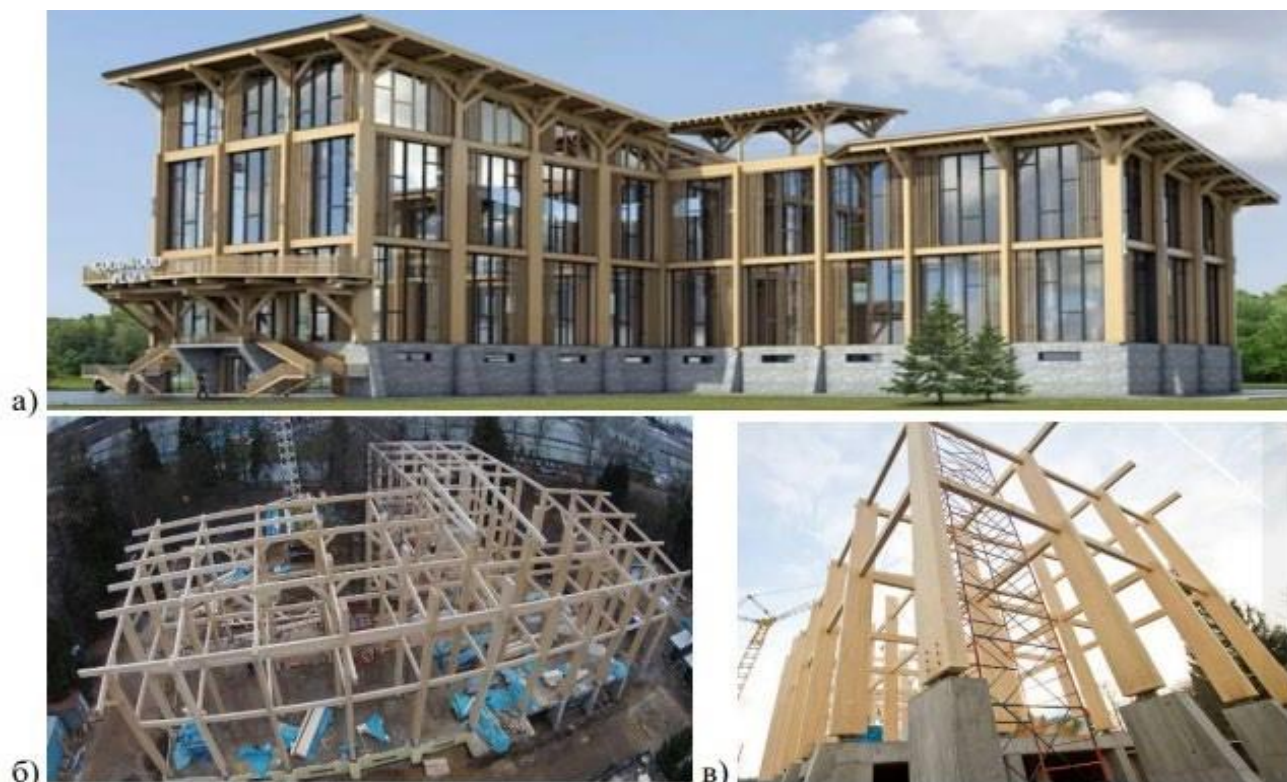
Рис. 8 - Офисное здание GOOD WOOD PLAZA: а) 3D модель здания; б) конструктивная система здания (фотография со строительной площадки); в) опирание колонн на железобетонную «основу» здания (фотография со строительной площадки)
