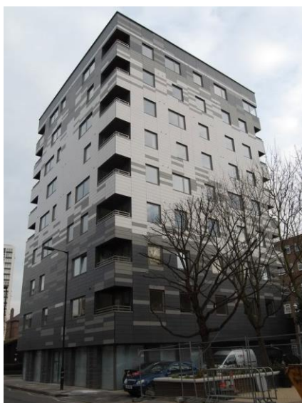
Рис. 1 - Многоэтажное жилое здание Stadhaus
