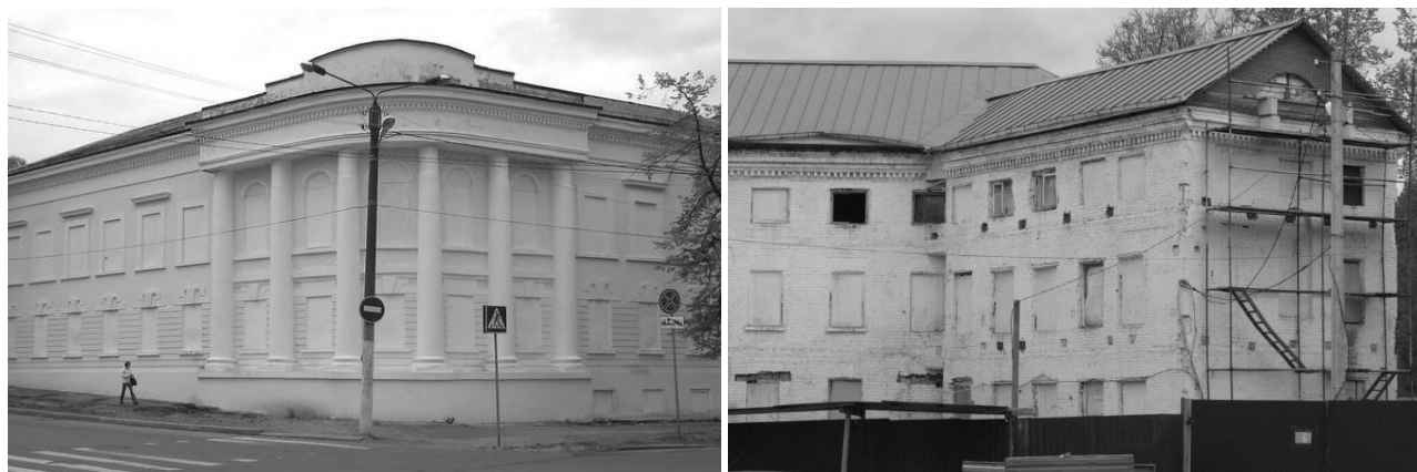
Рисунок 2 – Дом Соборного притча по ул. Чайковского
